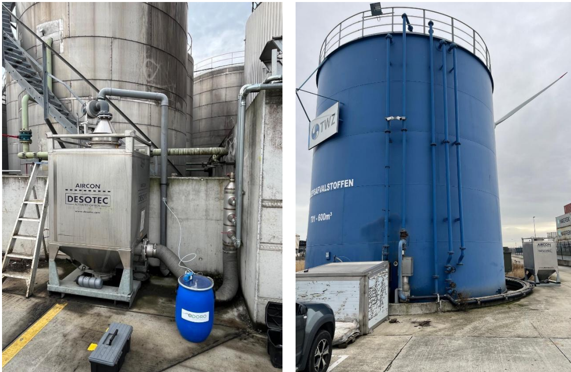
Figuur 1. Foto van de actieve koolfilters van tank 12 en 13 [links] en tank 01 [rechts]
