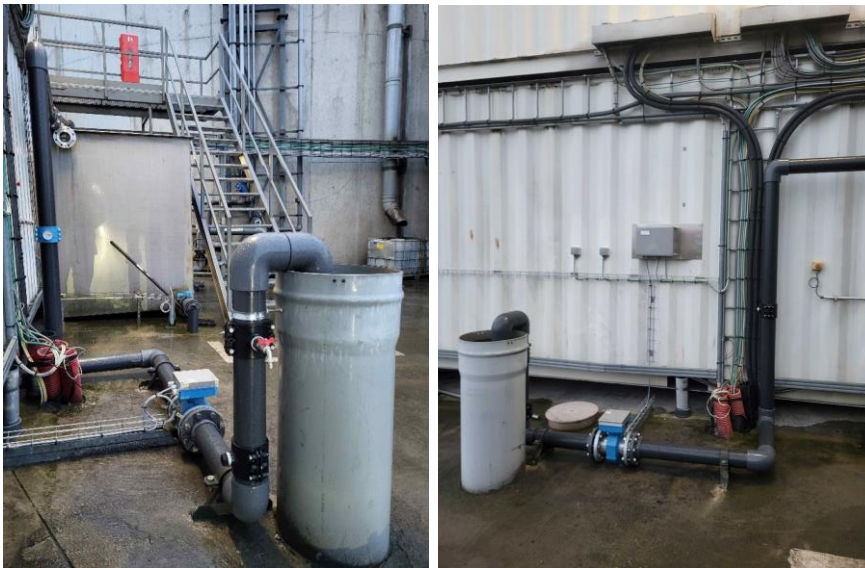
Figuur 6 – Nieuwe meter en staalnamepunt. (TWZ,2026)
