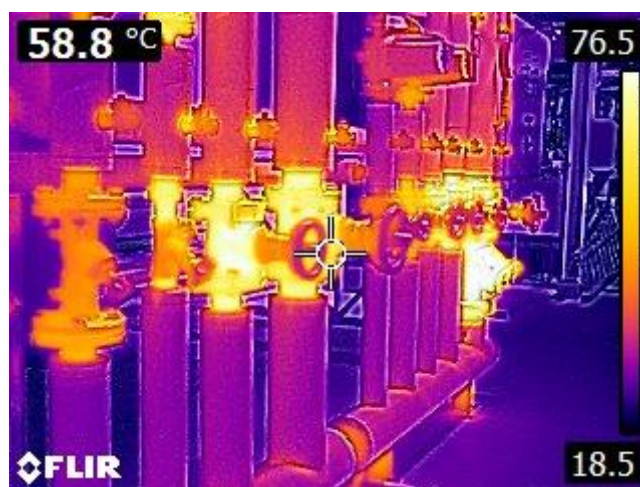
Figuur 11: Voorbeeld thermografische foto van warmteverlies door ongeïsoleerde appendages
