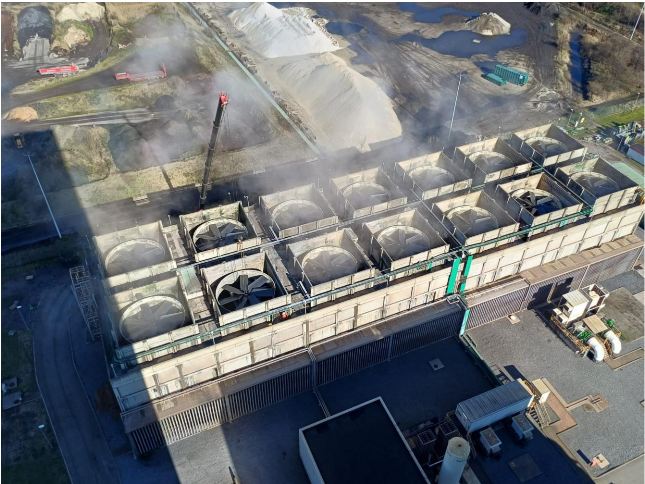
Figuur 9-2: Foto-weergave met ovenaanzicht van alle vervangen ventilatoren in de koeltorencellen
