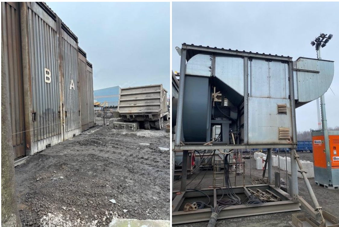
Figuur 1 : geluidbronnen tijdelijke brandwerf
