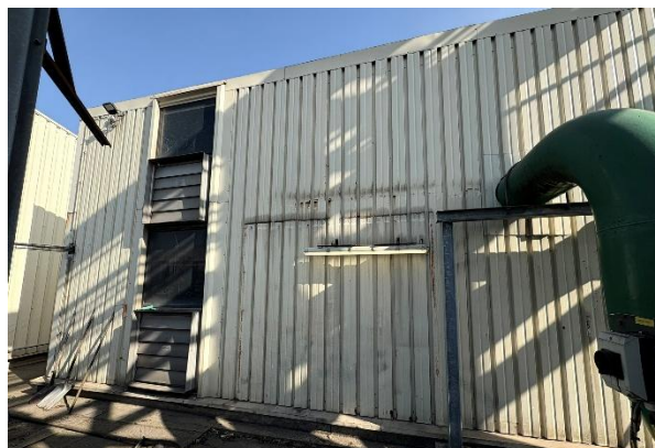
Zijgevel pomplokaal koelwaterpompen
