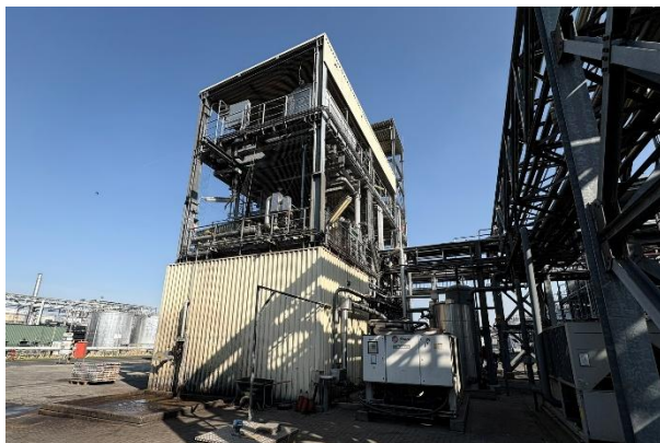
Zicht op biodiesel-installatie
