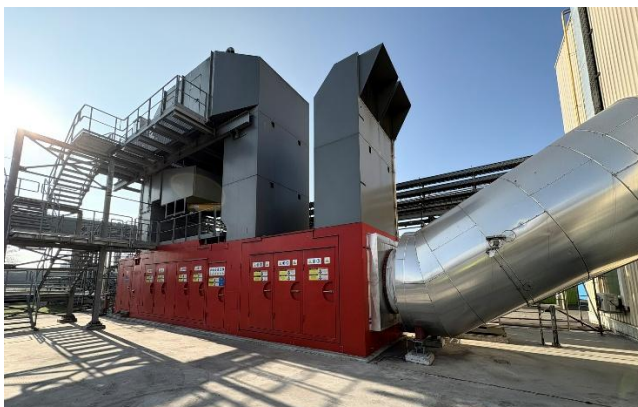
Aansluiting hete lucht uitgang WKK
