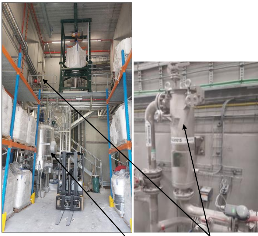
Figuur 4: Storttrechter bigbags en mengtank (links), luchtfilter op mengtank (rechts)
