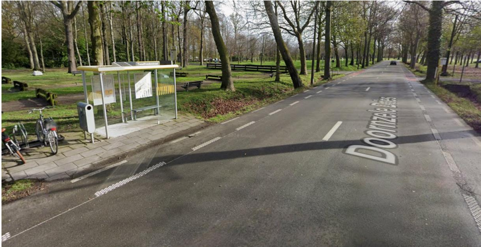
Figuur 12: Bushalte Evergem Twaalfroedenstraat
