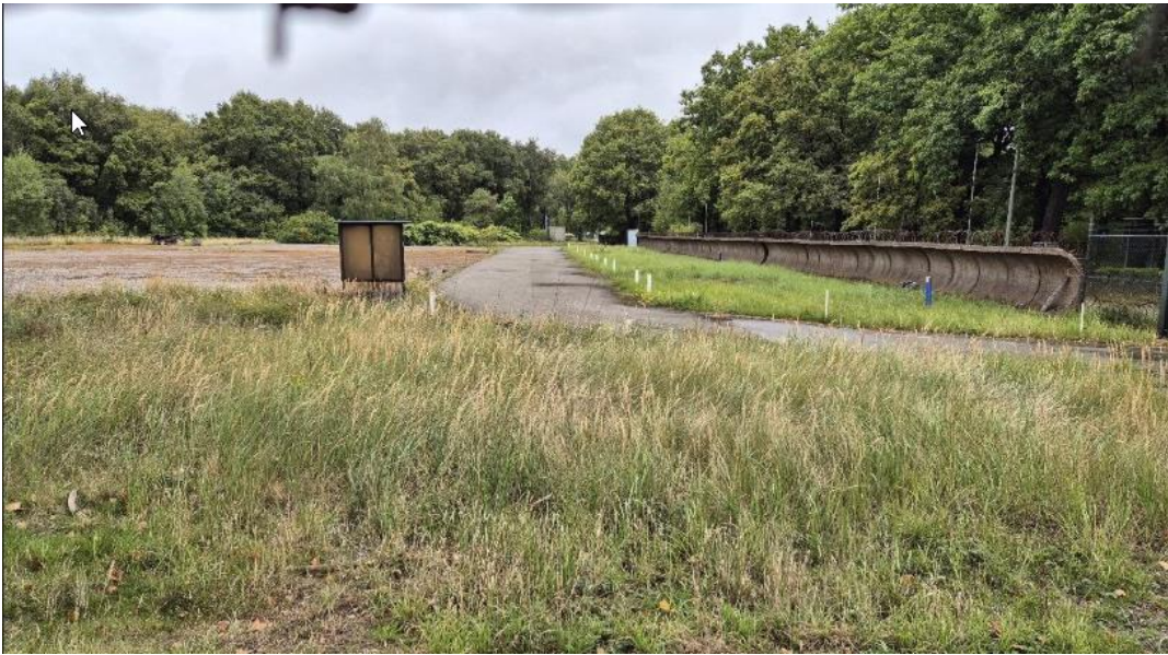
Figuur 18 : asfaltverharding op grondgebied Zelzate in bestemmingszone Bosgebied-koppelingsgebied
