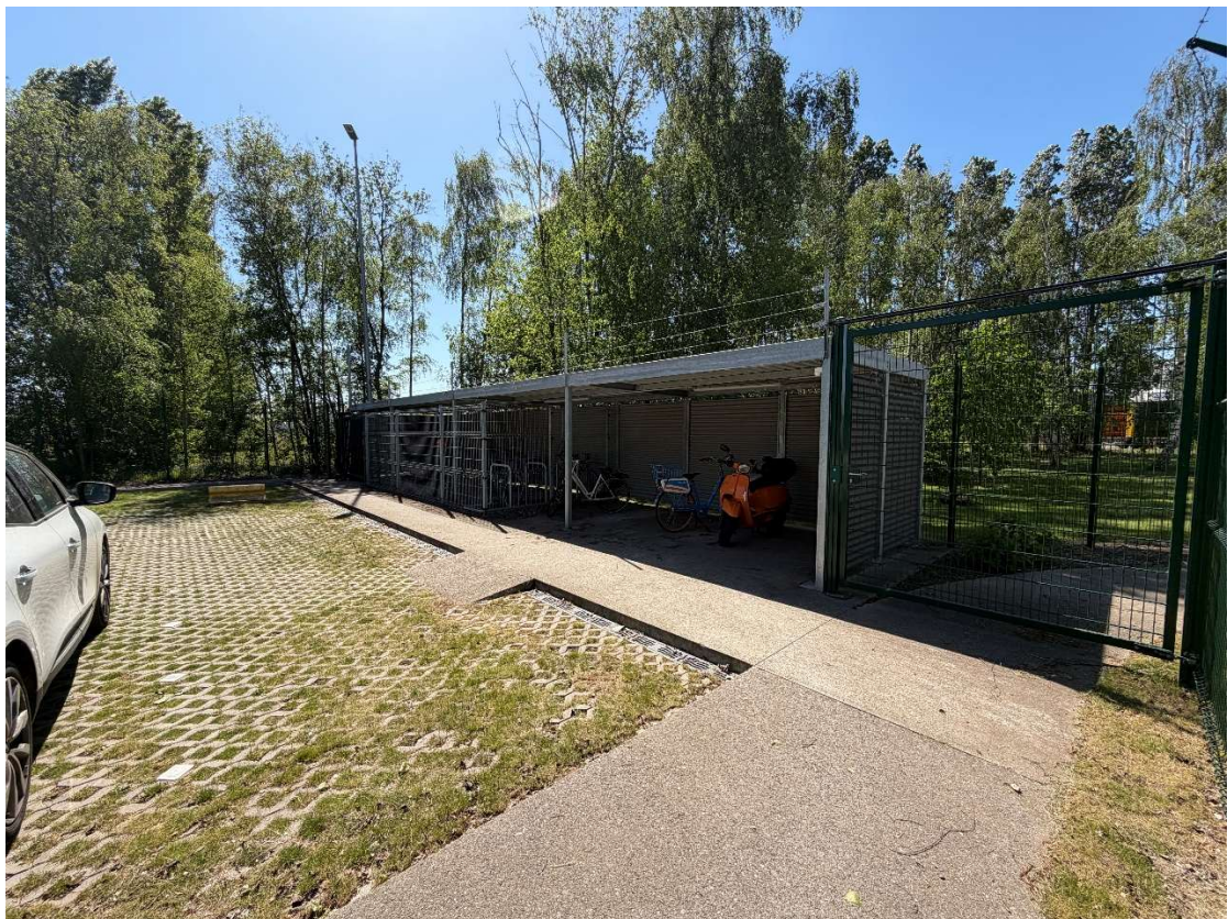
Figuur 1 Gebruik van de bestaande fietsenstalling op een normale werkdag
