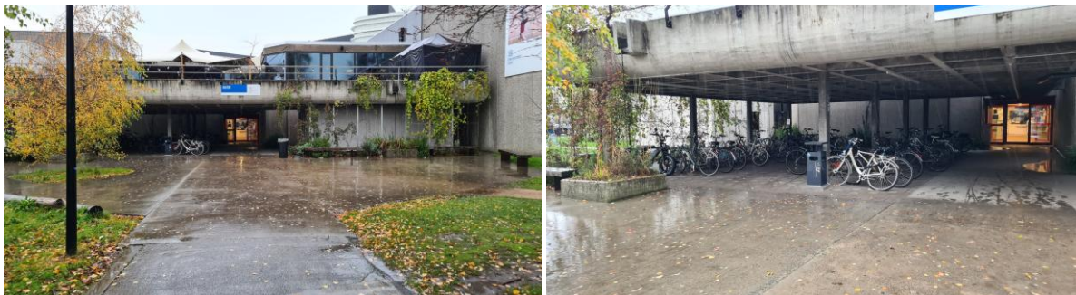
Figuur 8: Toegang tot GUSB + fietsenstalling (UGent)
