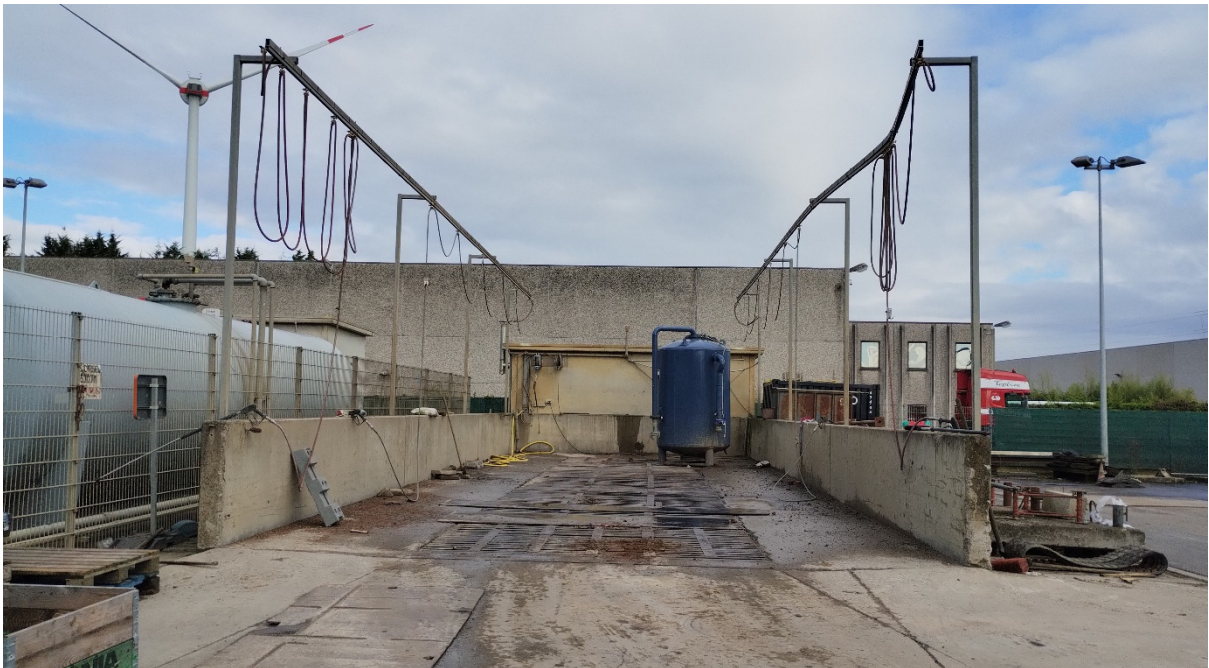
Figuur 6: De wasplaats voor vrachtwagens en ander materiaal, gelegen op het terrein van de technische dienst
