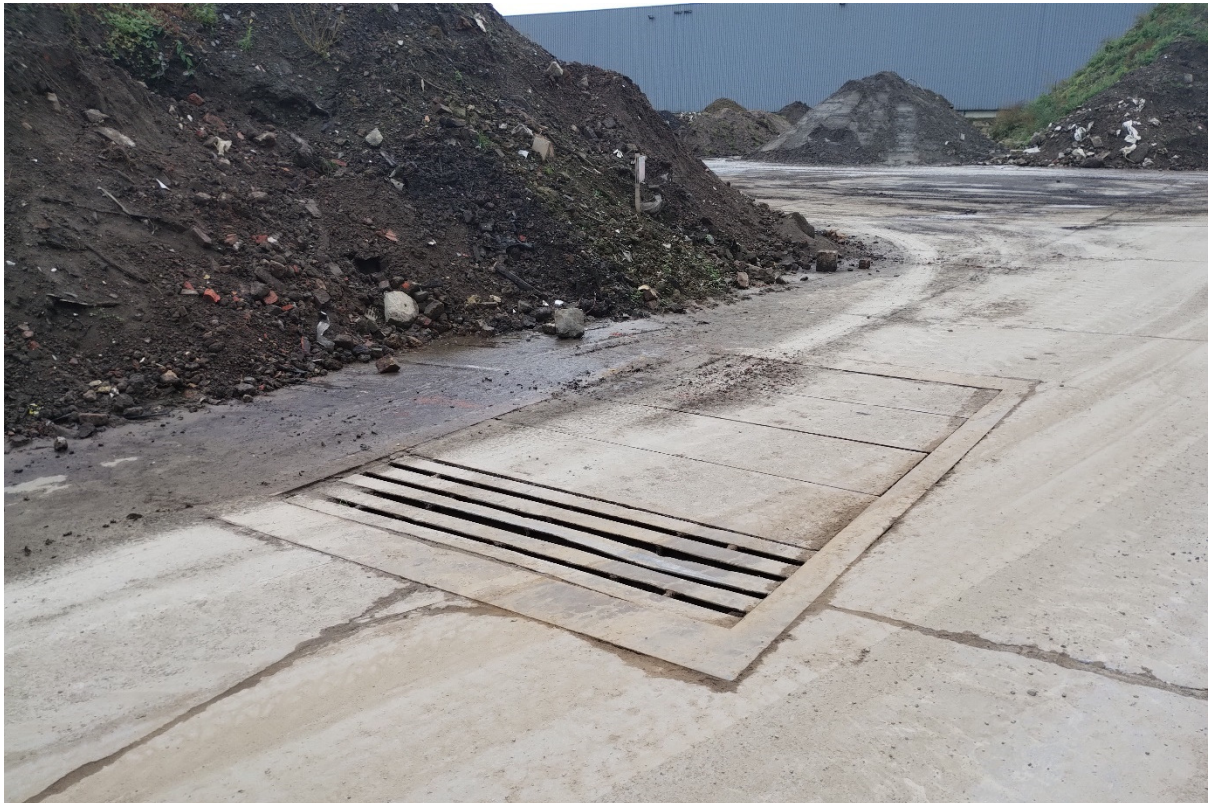
Figuur 3: voorbeeld van één van de zandvangen waarlangs afstromend hemelwater wordt verzameld en naar de WZI wordt gebracht
