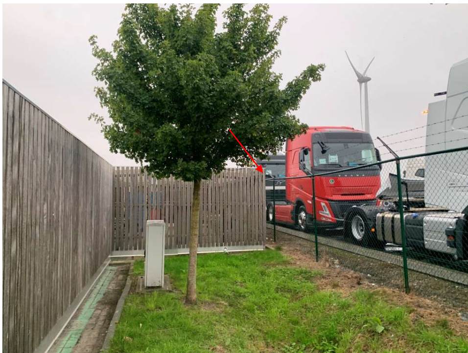
Situering van de locatie van automatische detector D2 aan de fietsenstalling van Parking Noord (Greenspot, 3 oktober 2025).
