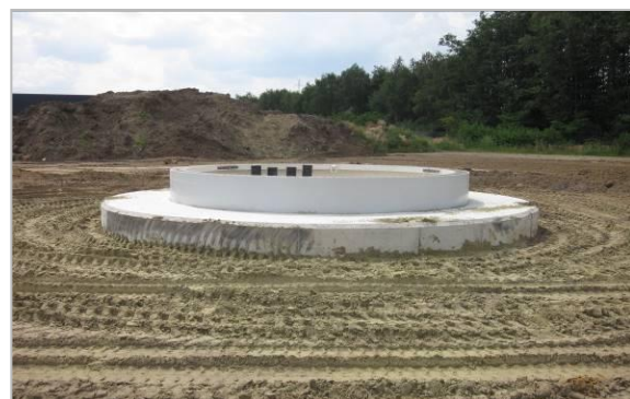
Figuur 31 : Afgewerkte fundering
