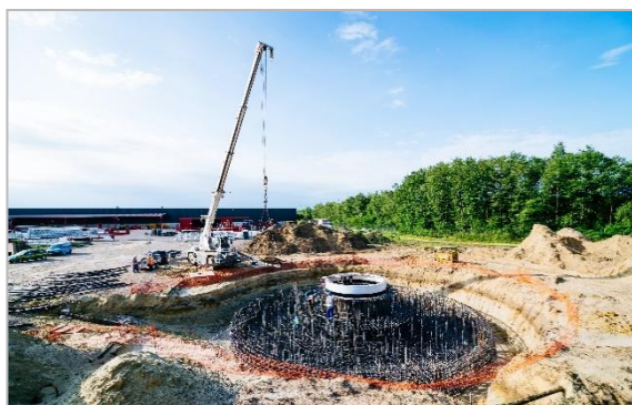
Figuur 30 : Constructie fundering
