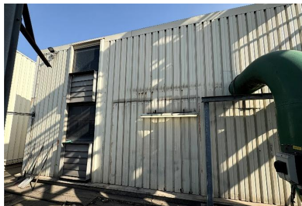
Zijgevel pomplokaal koelwaterpompen
