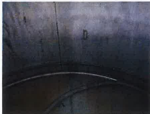
Figuur 2: Lasverbinding cilindrische wand met de bodem
