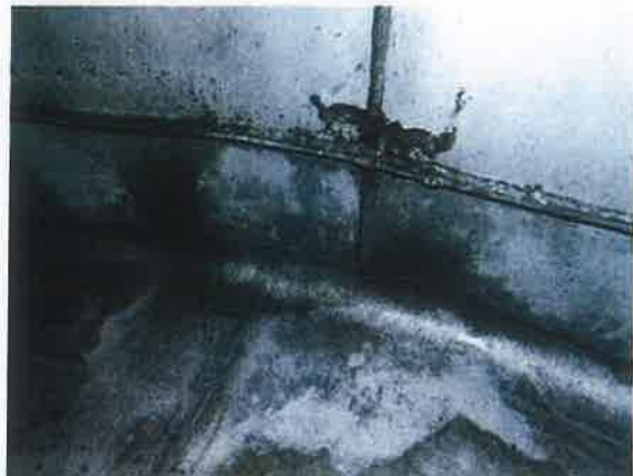
Figuur 4: Lasverbinding cilindrische wand met bodem
