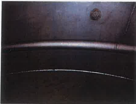
Figuur 3: Lasverbinding bodem met cilindriscie wand
