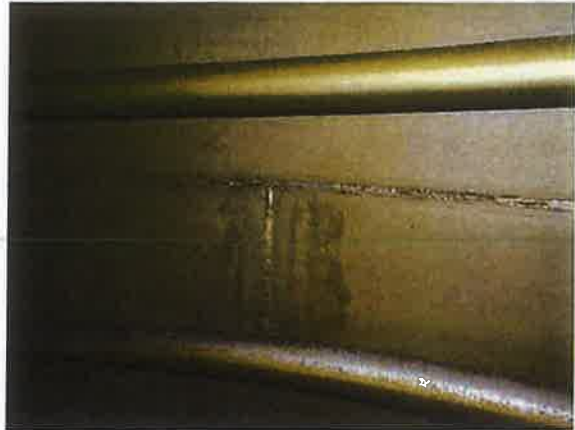
Figuur 2: Lasverbindingen cilindrische wand
