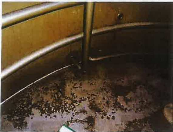
Figuur 3: Lasverbinding bodem met cilindrische wand
