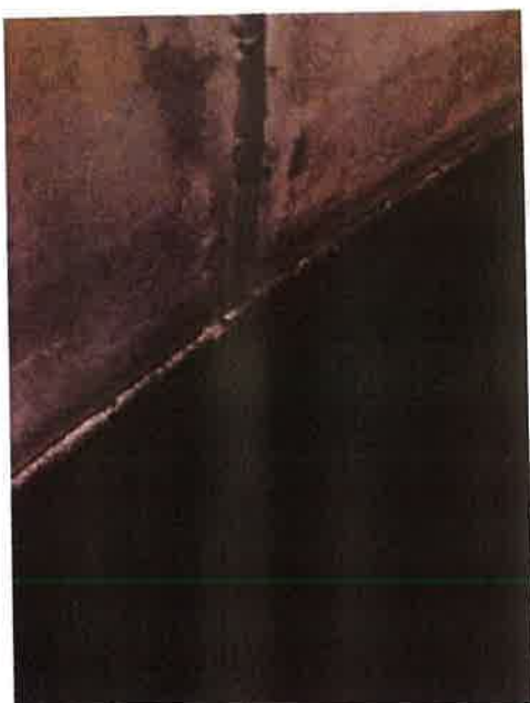
Figuur 3: Lasverbinding tussen bodem & tankwand
