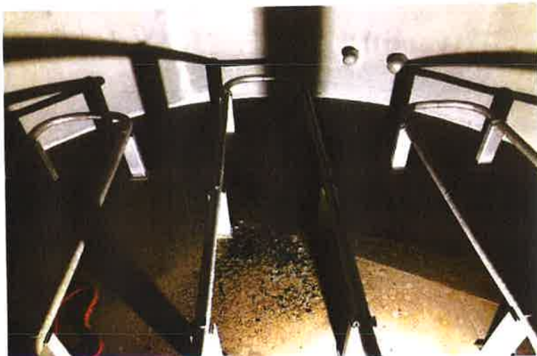
Figuur 2: Tankbodem met verwarmingsspiraal
