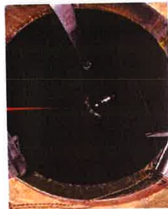
Figuur 6: Tankbodem gezien vanuit mangat
