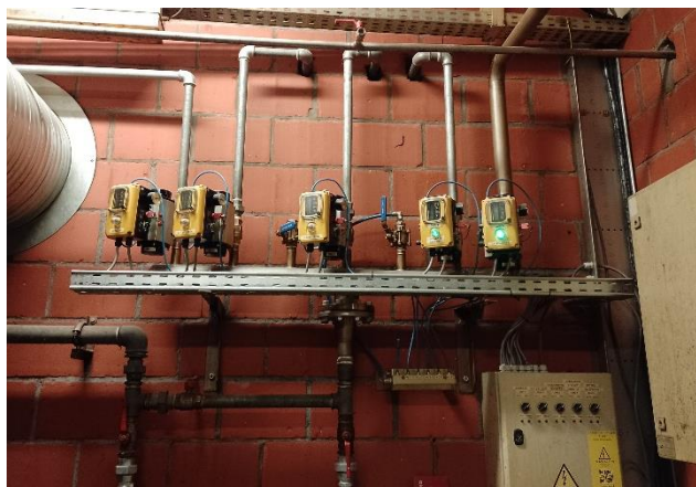
FIGUUR 32 VERTREKKEN PERSLUCHTCIRCUITS MET AUTOMATISCHE KLEPPEN
