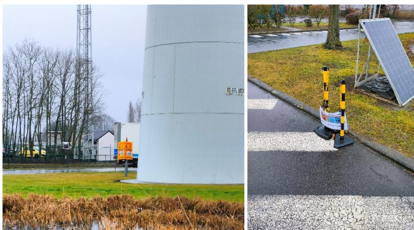
Figuur 33: Signalisatiebord voor ijsval aan de voet van VT WT3 en signalisatielint ter hoogte van de voetgangerszone
