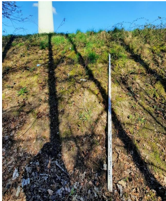
Figuur 5: Zicht op de ophoging vanaf het oorspronkelijke maaiveld. Op de achtergrond is de windmolen (binnen het plangebied gelegen) zichtbaar 12
