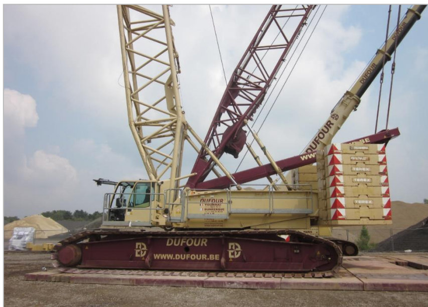
Figuur 36: Kraan op kraanplatform
