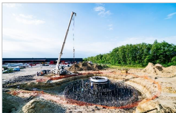
Figuur 33 : Constructie fundering
