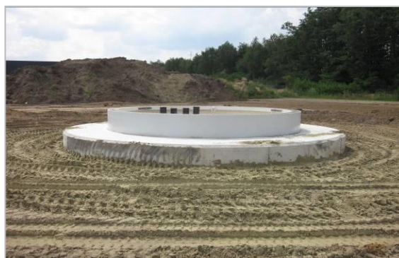
Figuur 34 : Afgewerkte fundering
