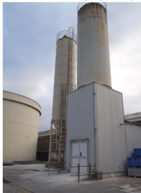
Foto F12: zone Z11: Opslag van ongebluste kalk (R33 en R34)
