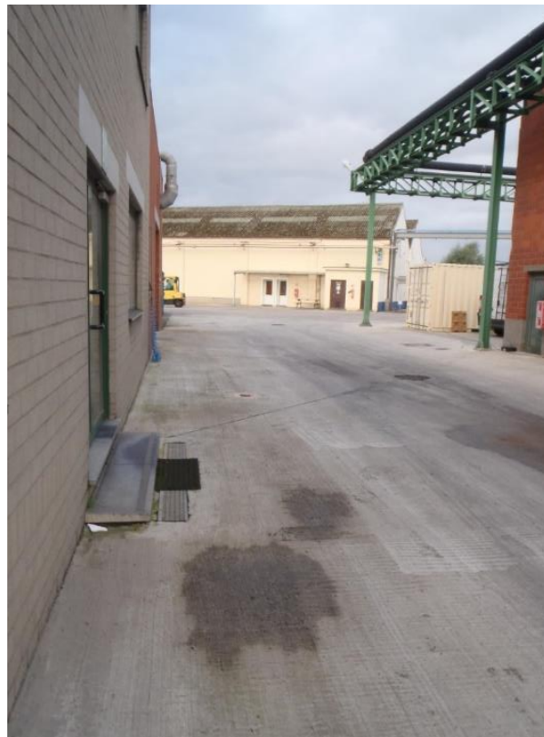
Foto F16: Zone Z15: Garagewerkplaats en bovengrondse lichte stookolietank 1,8 m 3 (R46); Zone Z17: Onderhoudswerkplaats; zicht op P202
