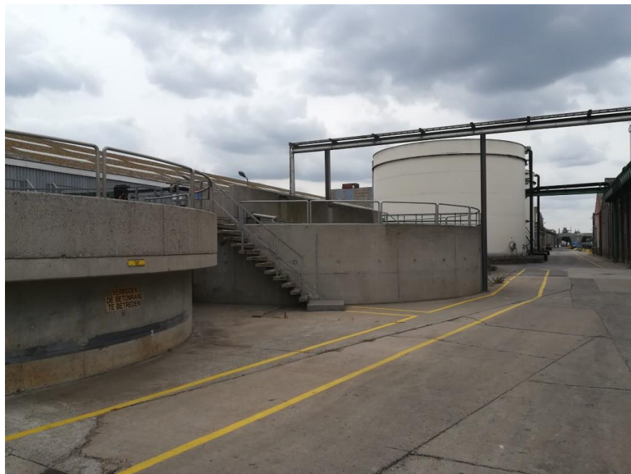
Foto F13: Zone Z13: Fysicochemische waterzuivering
