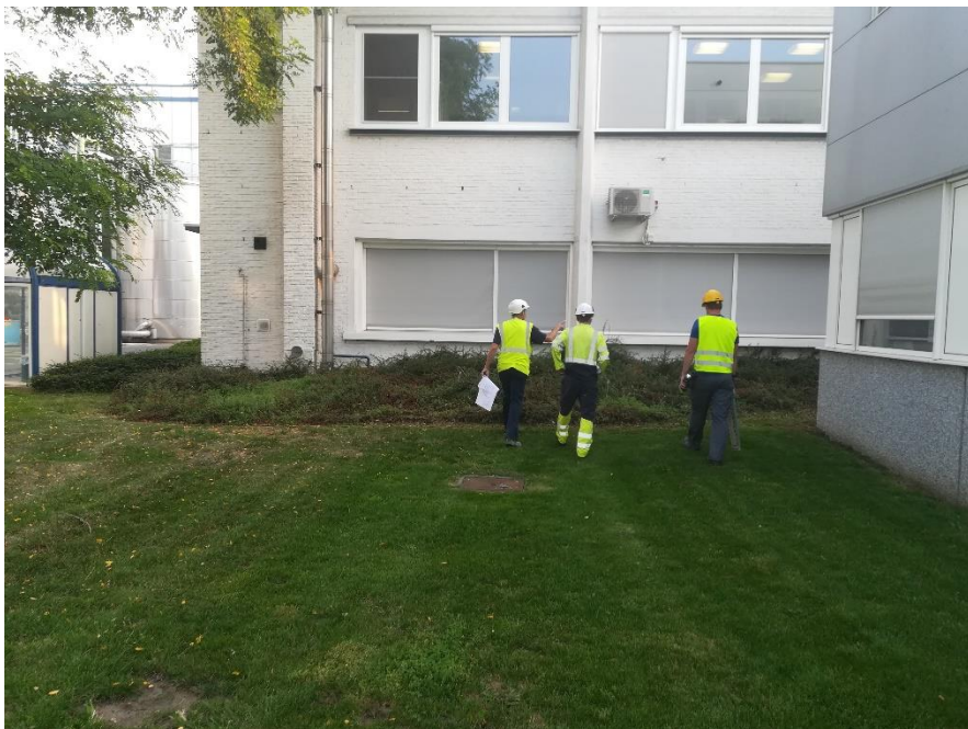
Foto F23: zone Z23: Groenzone rond labo, locatie P19005: puinhoudende grond vanaf maaiveld en asbestverdachte fragmenten vanaf 0,5 m
