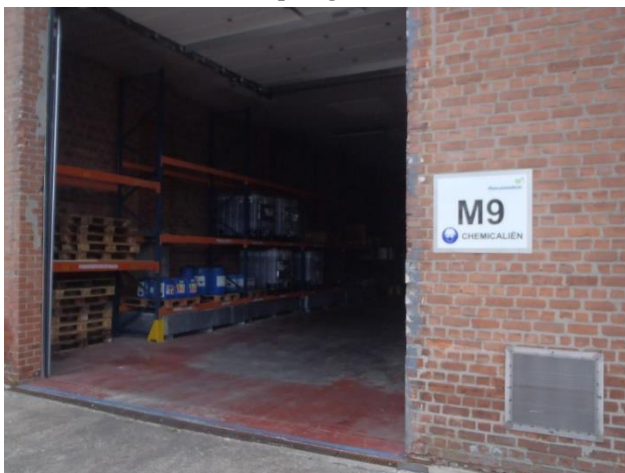
Foto F11: Zone Z10: Opslag van chemicaliën
