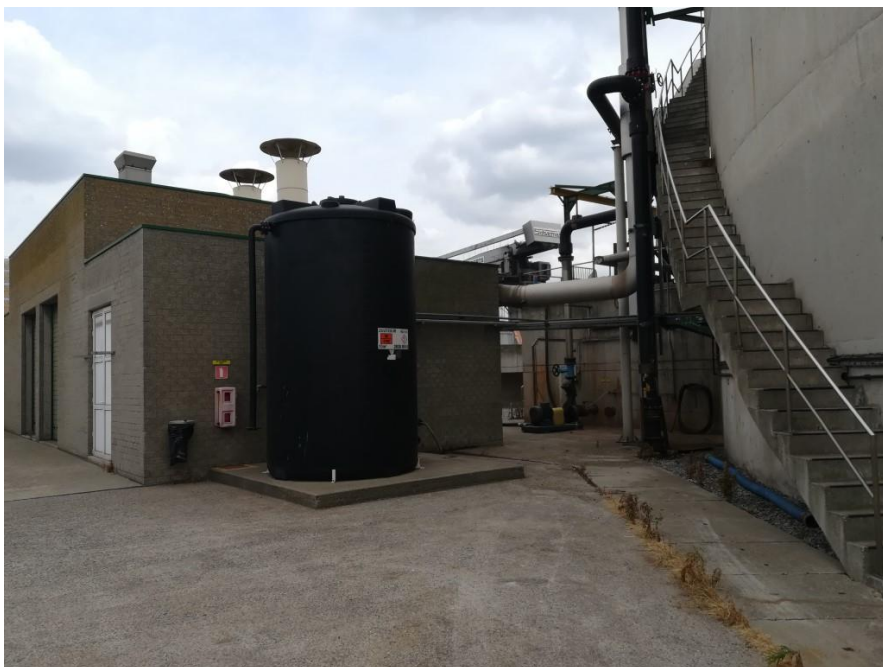
Foto F15: Zone Z14: Biologische waterzuivering met bovengrondse \text{H}_3\text{PO}_4 -tank 5,5 m 3 (R43), \text{FeCl}_3 -tank 5,5 m 3 en HCl-tank 10 m 3 (R53)
