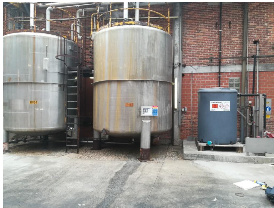
Foto F8: Zone Z7: Bovenggrondse H 3 PO 4 -tank 1,2 m 3 (R29)
