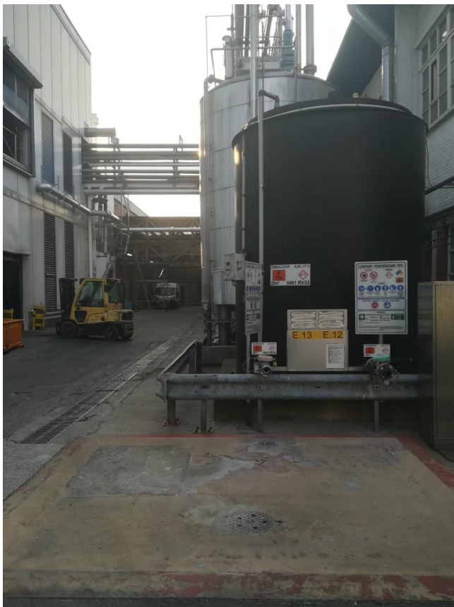
Foto F7: Zone Z6: Bovenggrondse HCl-tank 20 m 3 (R45)
