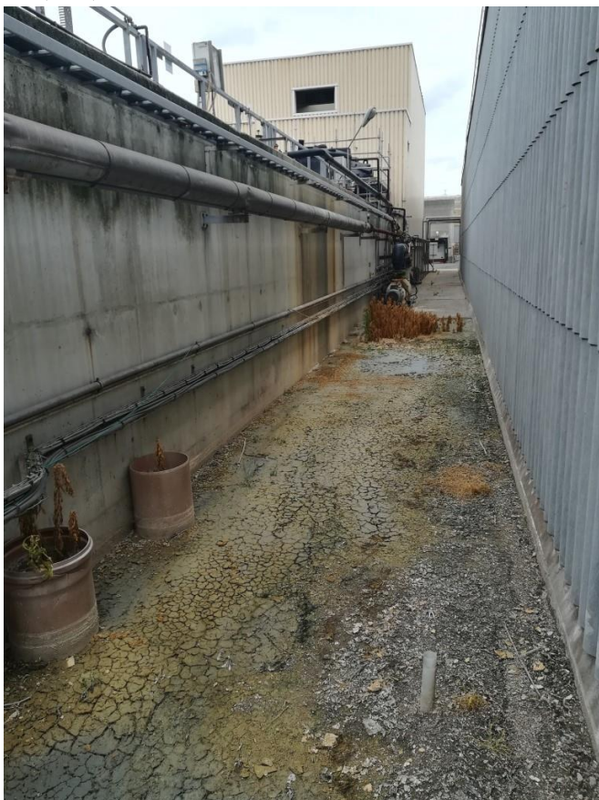
Foto F1: zone Z1: Bovengrondse HCl-tank 10 m 3 (R42) en FeCl 3 -tank 10 m 3 (R41)
