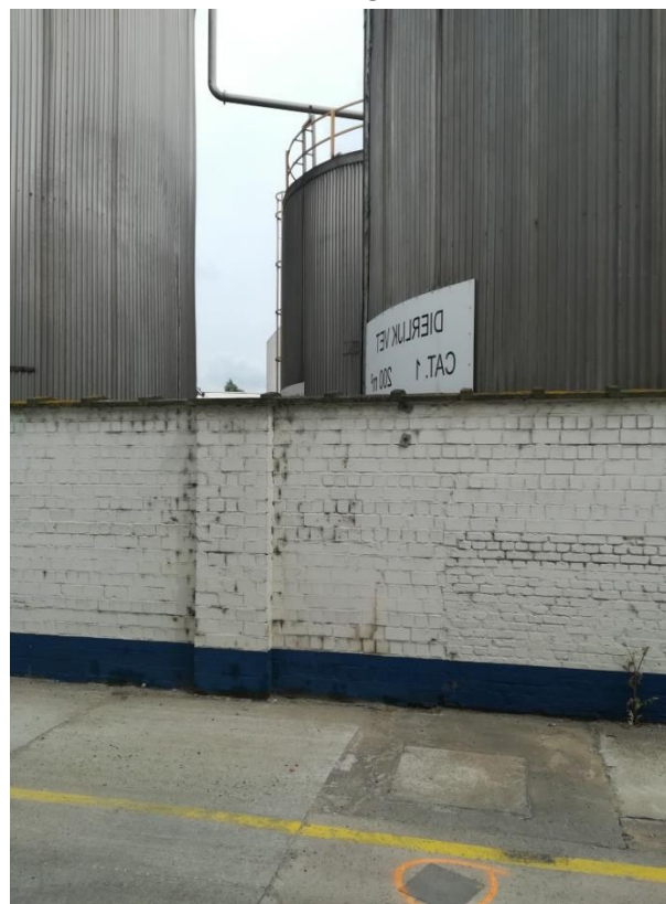
Foto F2: zone Z2: Twee voormalige bovengrondse zware stookolietanks 2 x 200 m 3 (R19), bovengrondse tank met dierlijk vet 385 m 3 , bovengrondse dieseltank 1 000 l en bovengrondse NaOH-tank 60 m 3 (R37)
