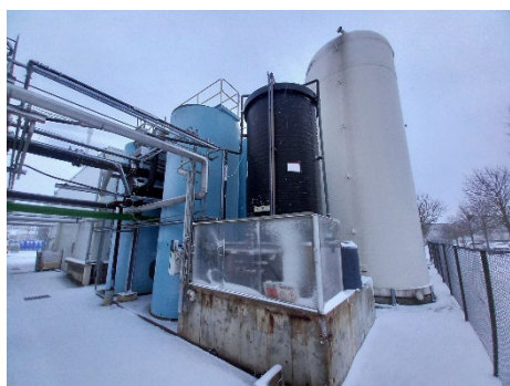
Foto opslagtank T1
