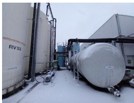
Foto opslagtank T2
