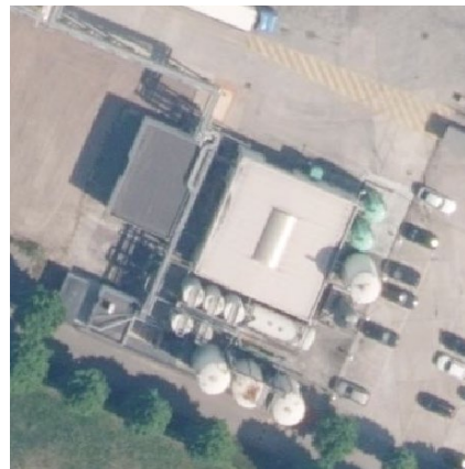
Actuele luchtfoto Geopunt
