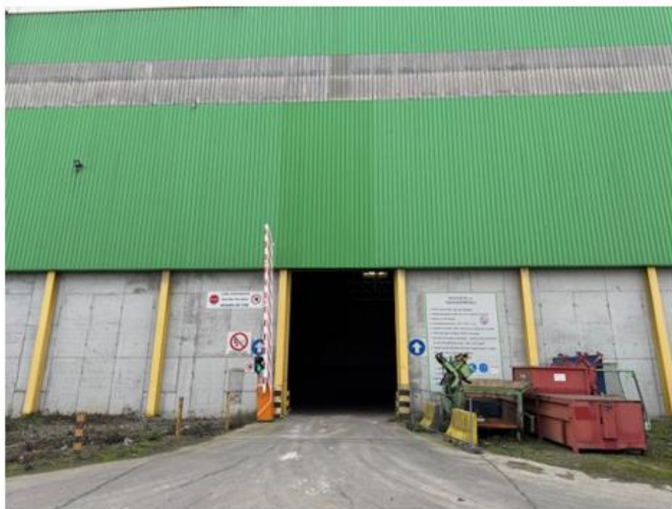
Foto 2: Voorzijde hal (zijde dichtst bij het kanaal)
