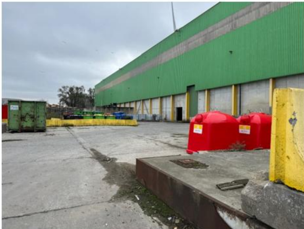
Foto 5 en 6: Linkerzijde hal
