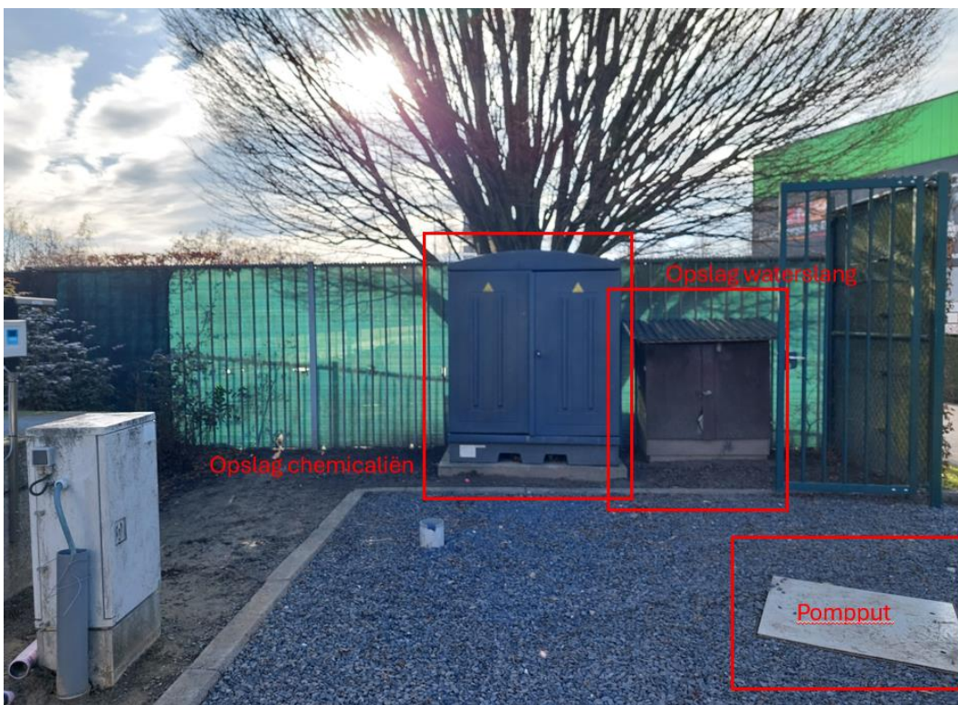
Figuur 3: Constructies voor opslag chemicaliën en waterslang en pompput
