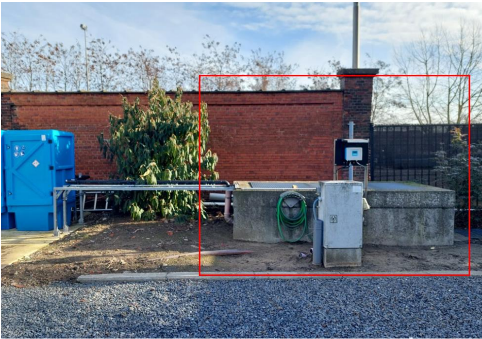
Figuur 2: Elektriciteitskast en venturi meetgoot
