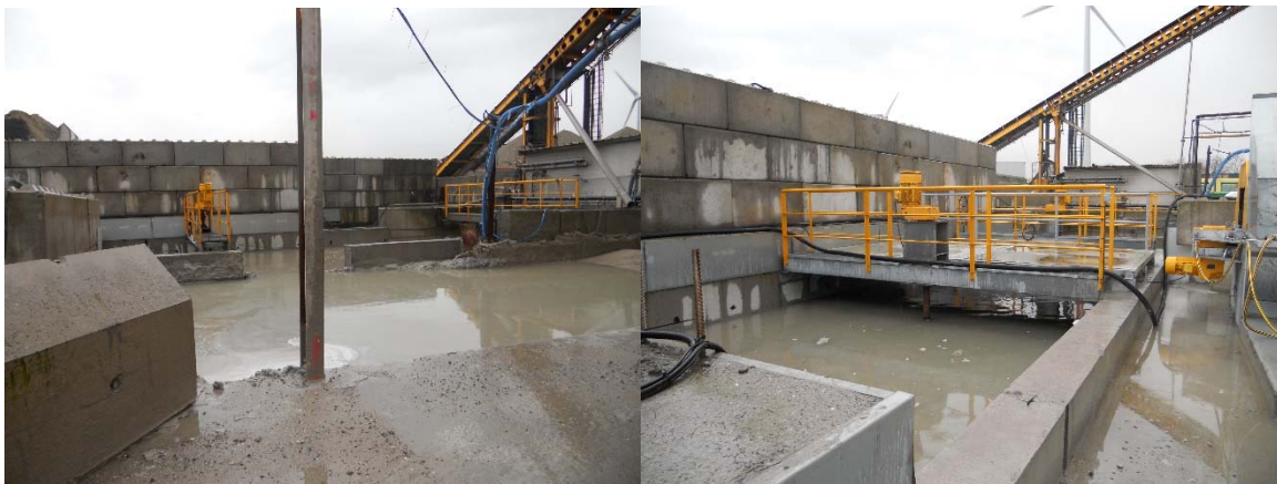
Figuur 5 Foto's spoelput en recuperatiewaterbekken bij Trans-Beton NV Gent ( bron : controlebezoek 22 november 2017)
