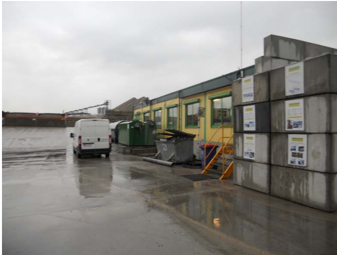
Figuur 7 Foto tankpiste nabij bureelcontainer bij Trans -Beton NV Gent ( bron : controlebezoek 22 november 2017)
