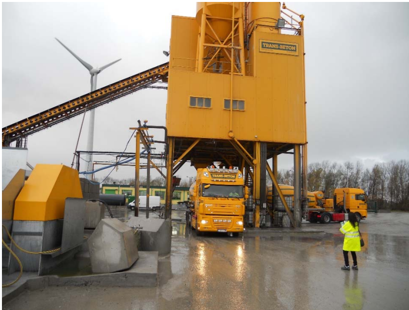
Figuur 6 Foto spoelzone bij Trans -Beton NV Gent ( bron : controlebezoek 22 november 2017)
