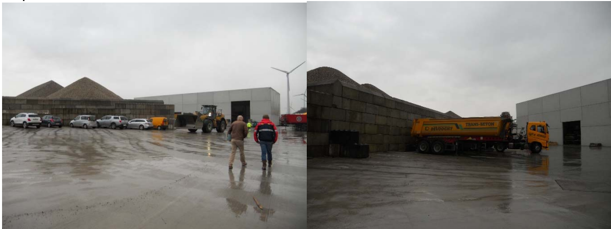
Figuur 2 Foto's nieuwe loods en parking/wegenis (bron : controlebezoek 28 november 2017)
