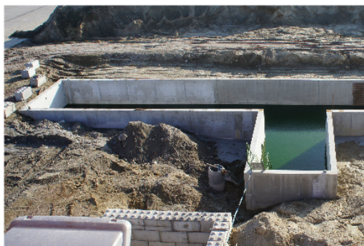
Figuur 4 Foto's ondergrondse grondstoffensilo's bij Trans-Beton NV Gent in opbouw ( bron : www.trans-beton.be )
