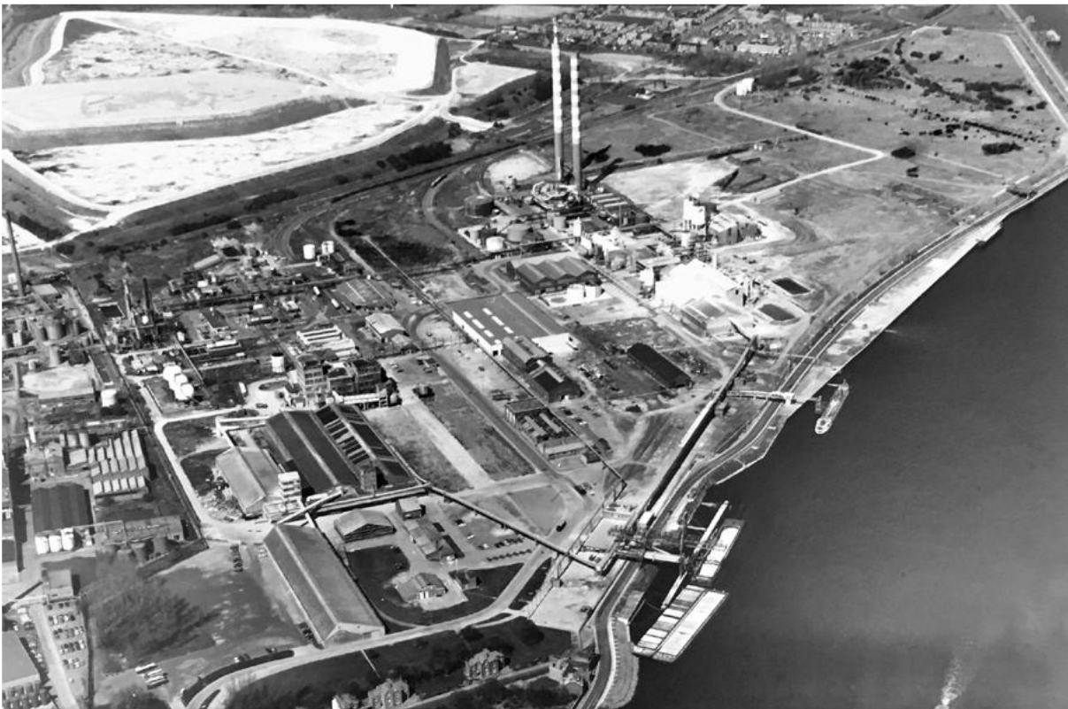
Figuur 3-4 Terreinen Kuhlmannkaai in de jaren 60 – begin jaren 70, na de verwijdering van de gas- en cokesfabriek en de uitbreiding van het Kanaal Gent-Terneuzen.
