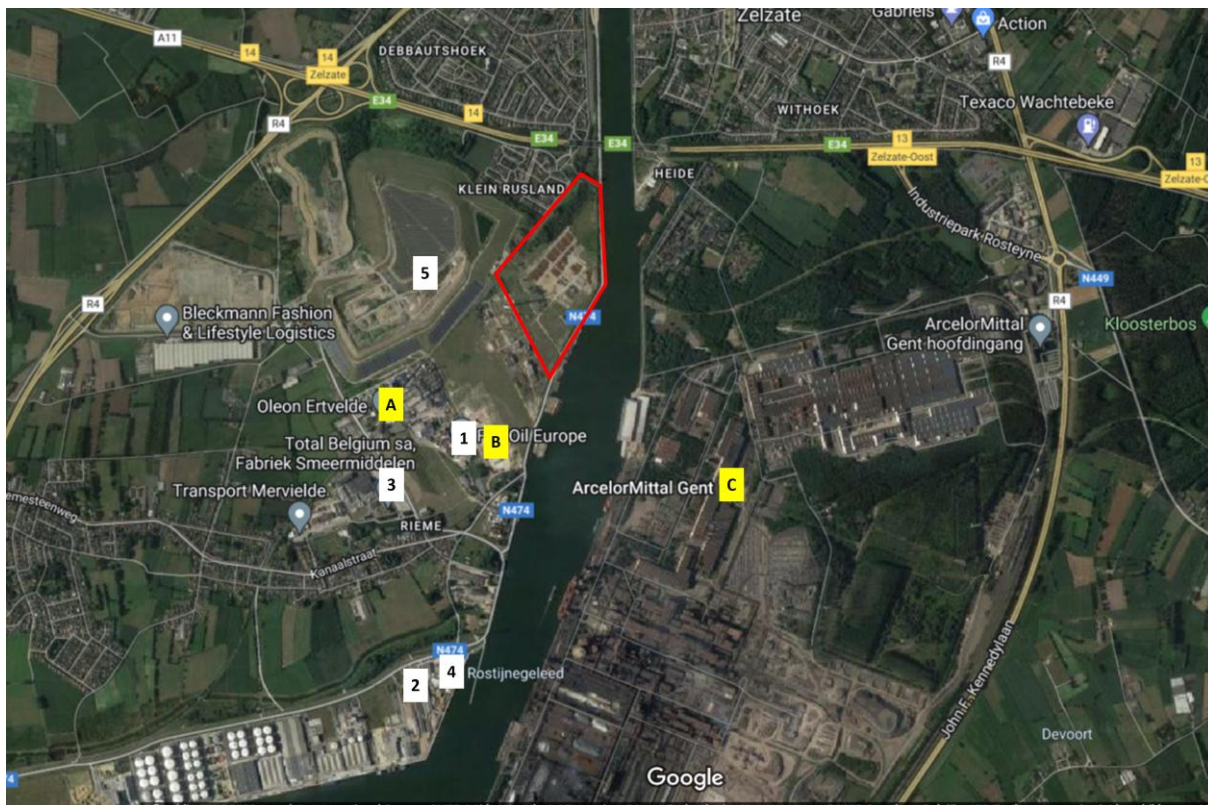
Figuur 7-44 Bedrijven in de omgeving van het projectgebied (zie rode omkadering): Fuji Oil Europe (1), Transferium (2), Total Belgium smeermiddelen (3), Trans-Beton (4), Terranova en het slibstort Callemansputte (5), en Seveso-inrichtingen (A) Oleon, (B) Transport Mervielde, (C) Arcelor-Mittal (bron: google maps, consultatie dd. 06/04/2023).
