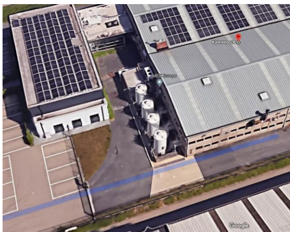
Figuur 1: Luchtfoto – situering van de opslagtanks en de losplaats
