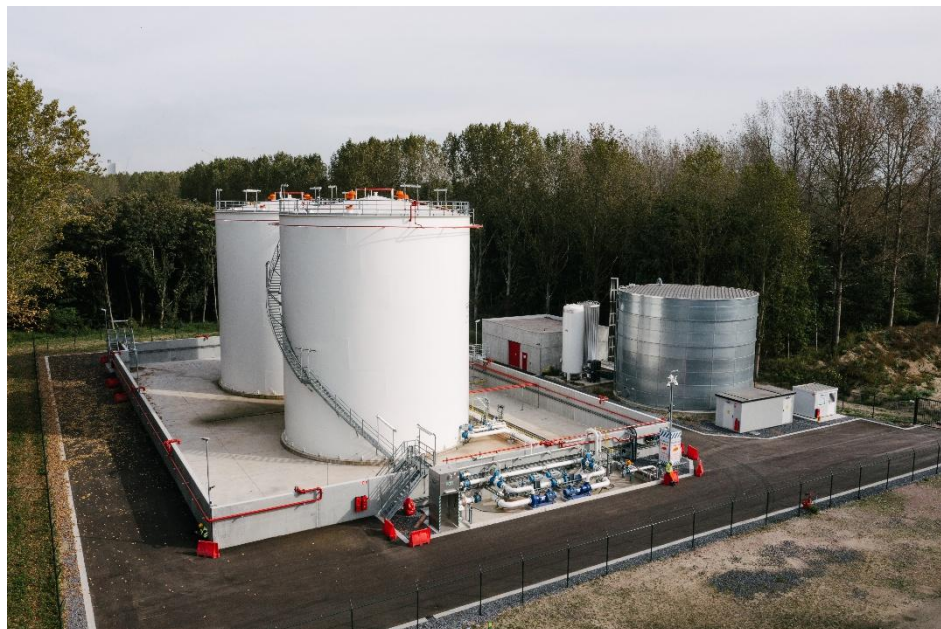
Figuur 4: Huidige situatie zuidoostelijke hoek van het plangebied. 7
