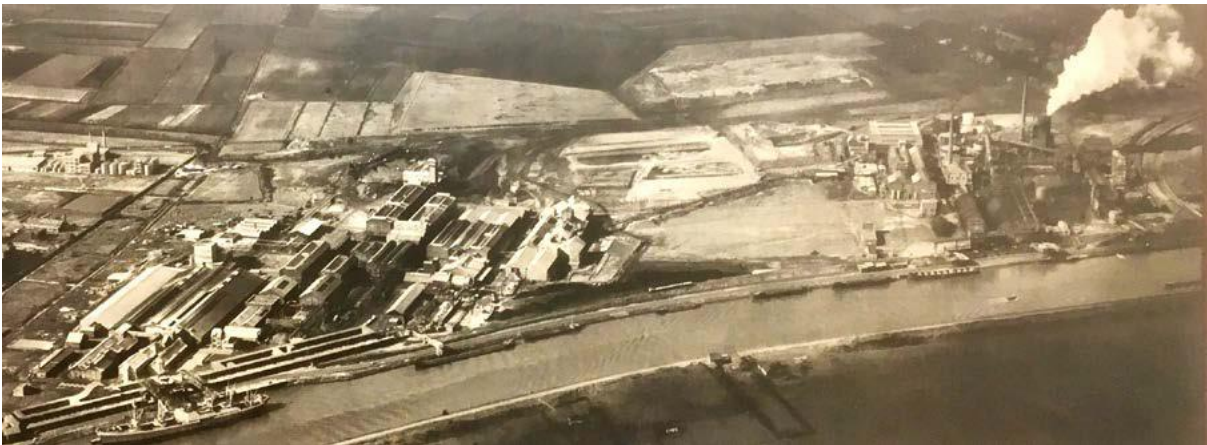
Figuur 3-3 Terreinen Kuhlmannkaai met rechts de cokes- en gasfabriek, in het midden stort van gips op het terrein en op de achtergrond, aan de overkant van de spoorweg het begin van de gipsberg. Foto genomen voor de verbreding van het Kanaal Gent - Terneuzen, waarschijnlijk in de jaren 50-begin jaren 60.
