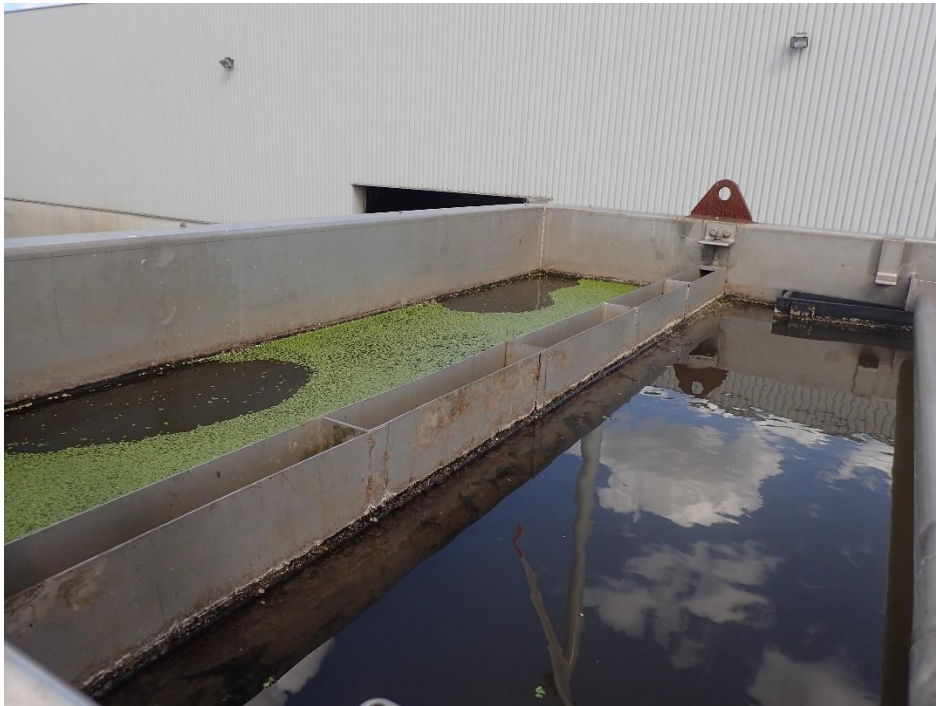
Figuur 6: Bovenaanzicht lamellenbezinker
