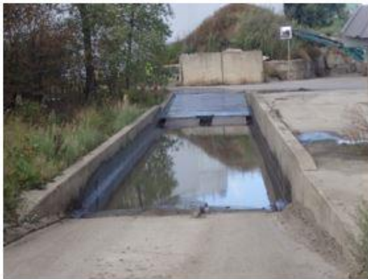
Figuur 17: Voorbeeld wielwasinstallatie
