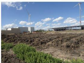
Figuur 14: Laguneringsbekken wordt op ruggen gezet
