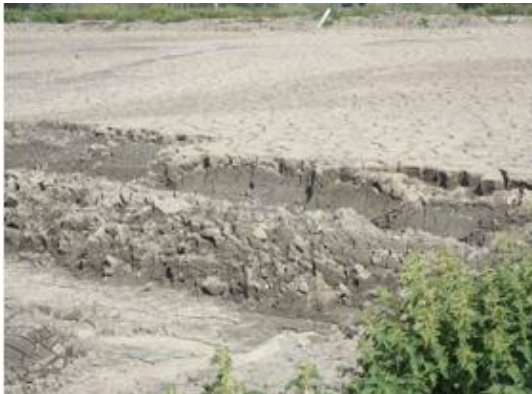
Figuur 15: Laguneringsbekken: ruggen binnenin plastisch door vocht
