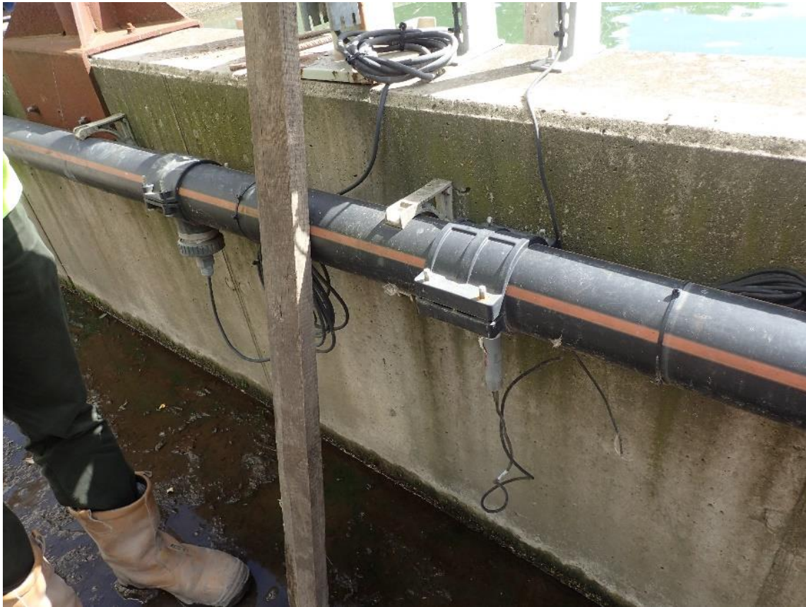
Figuur 7: Effluentleiding waar kwaliteitsmeting plaatsvindt
