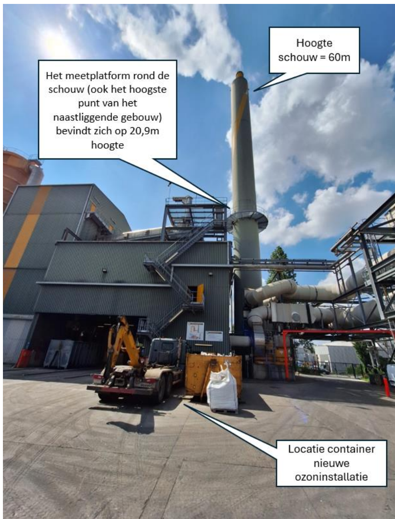
Figuur 3: Foto locatie nieuwe container ozoninstallatie
