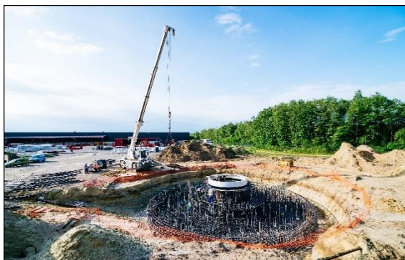
Figuur 17 : Constructie fundering
