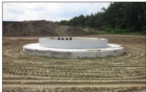
Figuur 18 : Afgewerkte fundering
