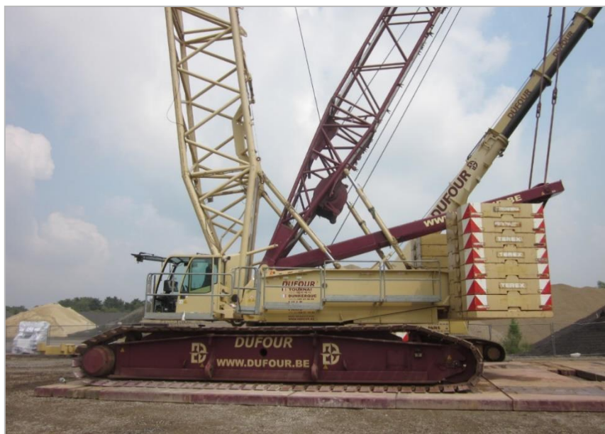
Figuur 20: Kraan op kraanplatform
