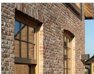
Buitenschrijnwerk (ramen en deuren)
