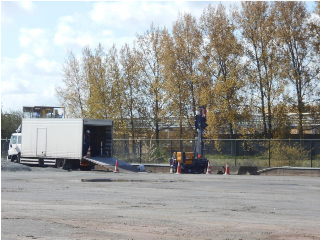
Foto 3: Plaatsen peilbuis E508
