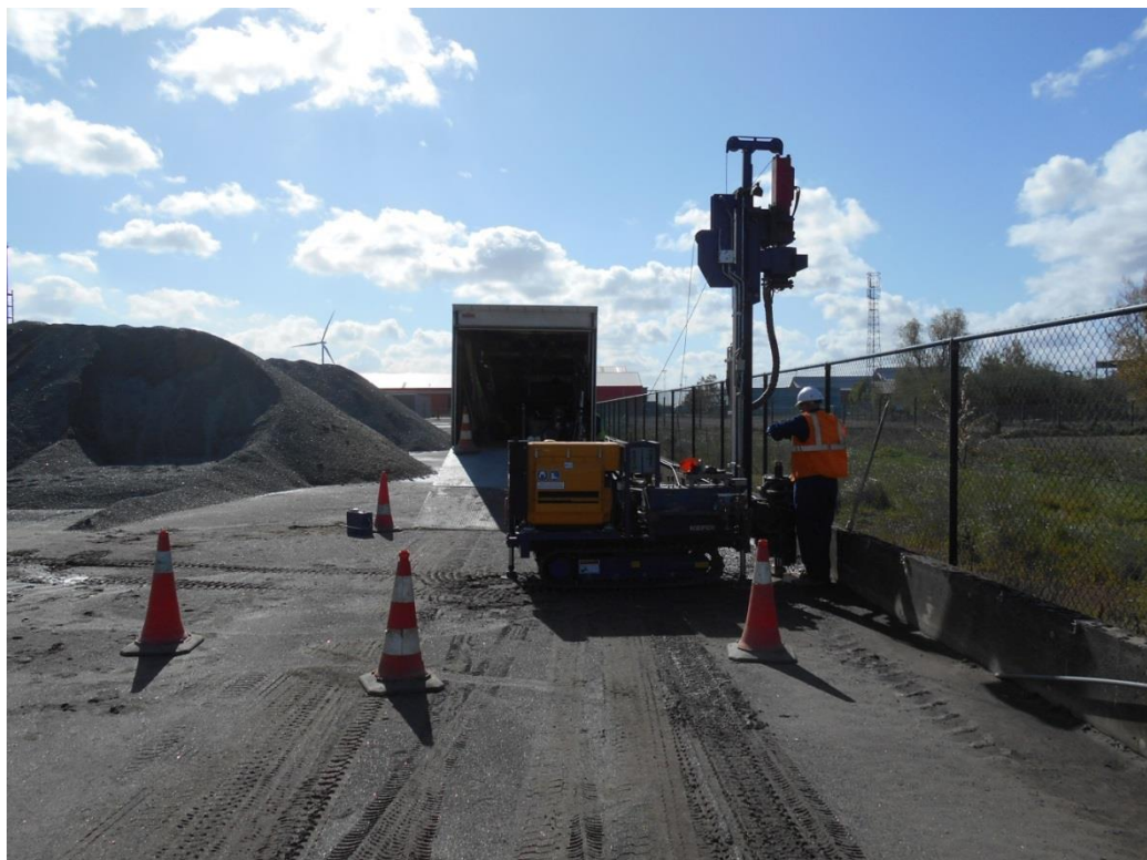
Foto 4: Plaatsen peilbuis E508
