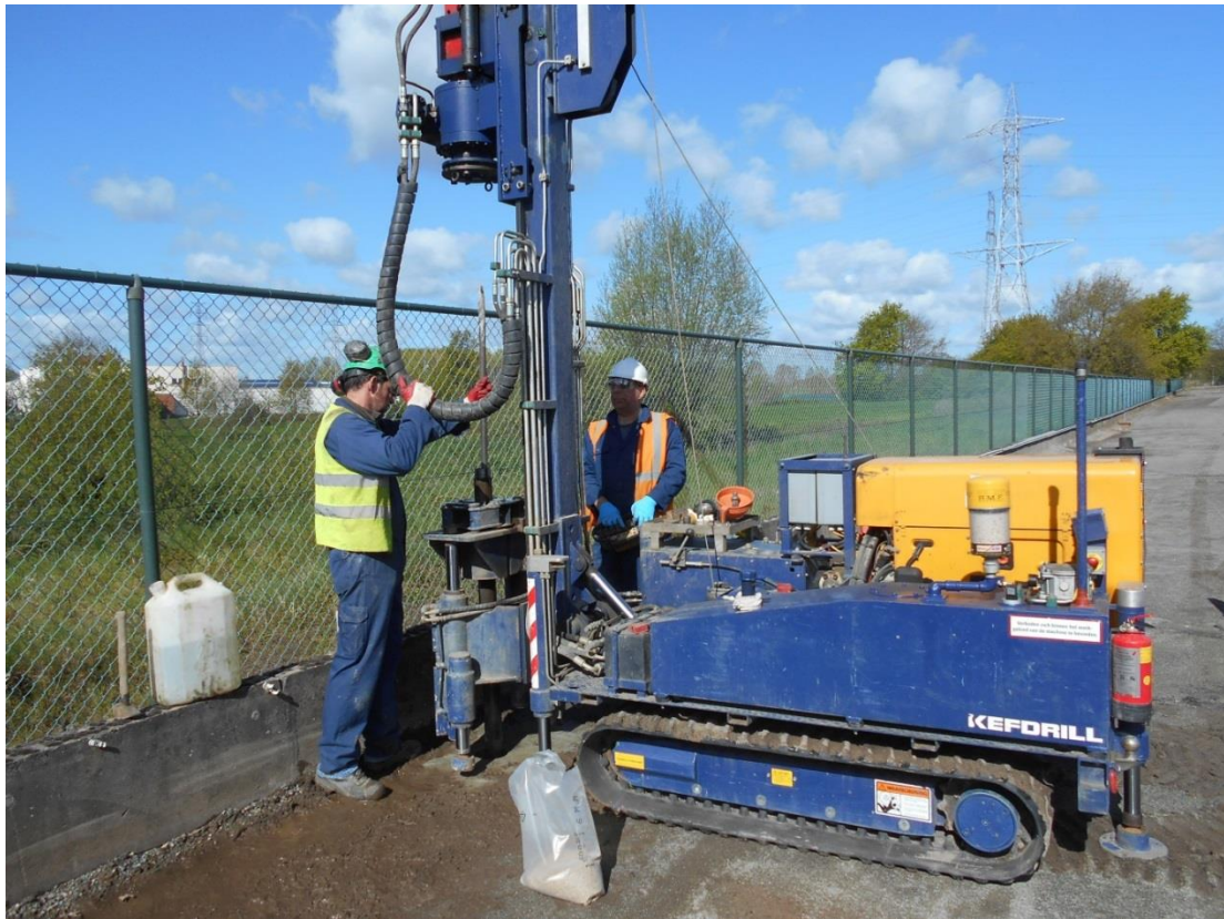
Foto 5: Plaatsen peilbuis E508
