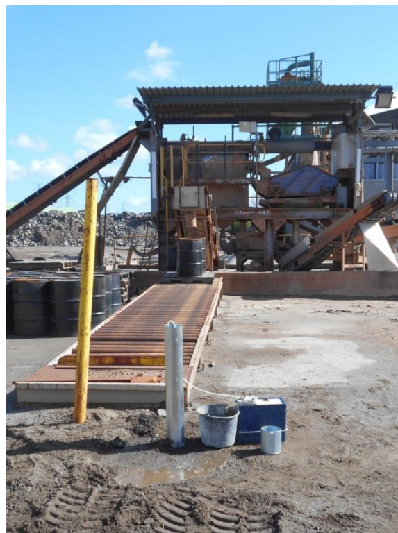
Foto 2: Doorpompen peilbuis E506
