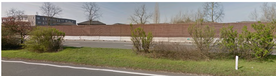
Geluidsschermen langs R4 west t.h.v. Evergem
