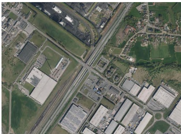
Figuur 2-12 Gerealiseerd knooppunt O7 Skaldenstraat (bron: Geopunt)
