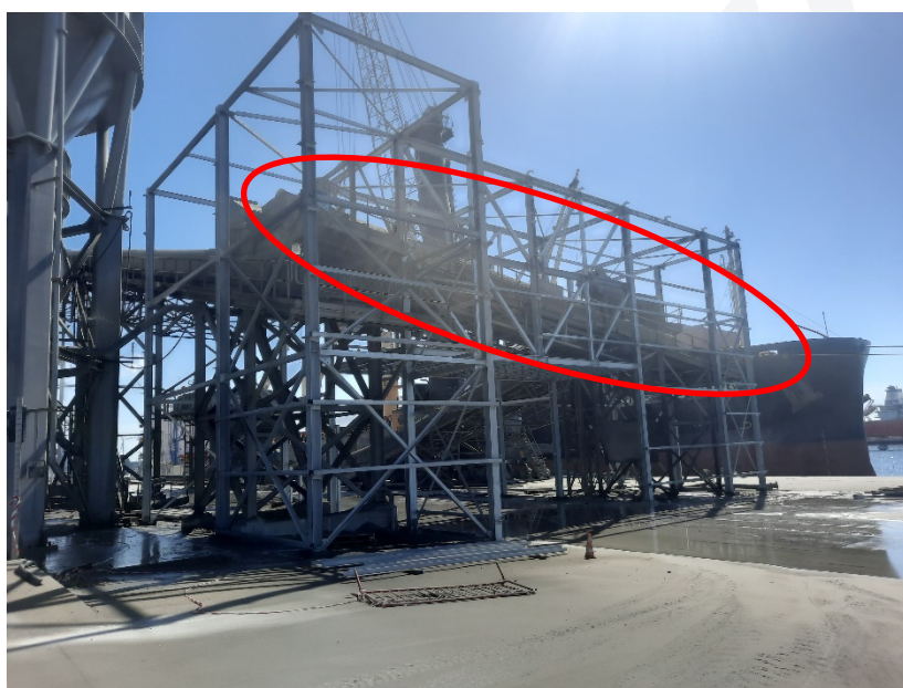
Figuur 7 Stofvrijstelling (rood omcirkeld) aan stortpunten transportbanden
