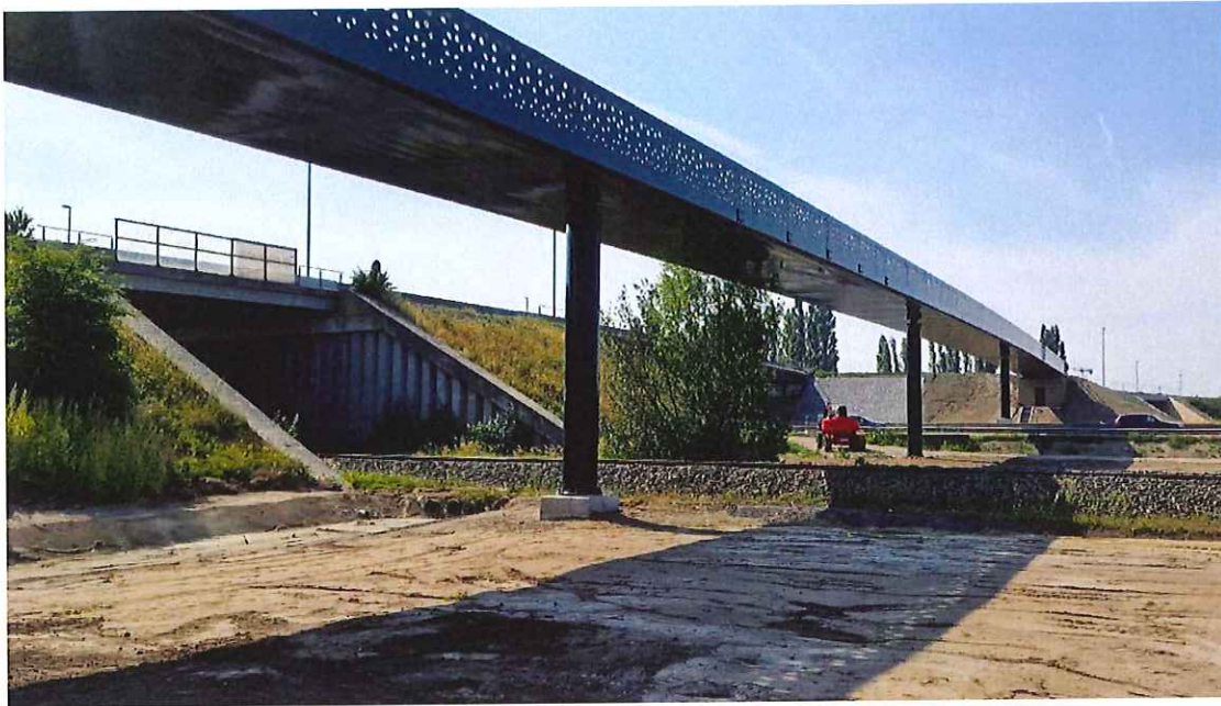
Figuur 7-5 Zicht op de fietsbrug ter hoogte van het ovaal van Wippelgem
