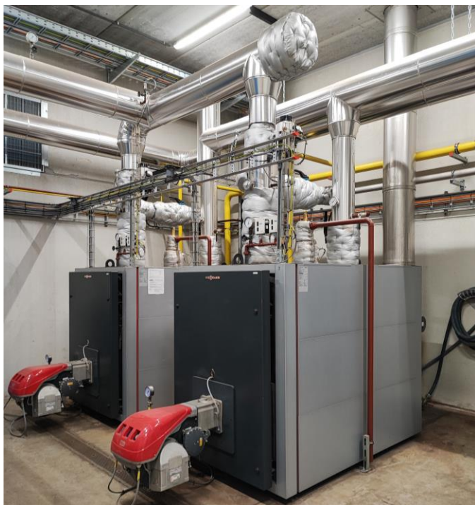
Voorbeeldfoto met isolatiematrassen (Sea-Tank Terminal Gent, nieuw stooklokaal)
