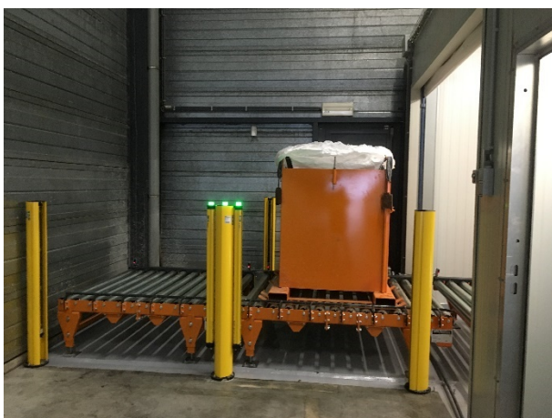
Figuur 7 Voorbereide asbest bigbag carrier op de rollerbaan van materiaalsas
