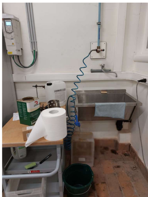
Foto 1 uitgietskaf naast trekkast waar beperkt met PMGE gewerkt wordt (sifon af te koppelen als preventiemaatregel)
