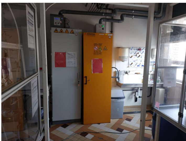
Foto 3 uitgietsbak naast trekkast waar beperkt met PMGE gewerkt wordt (sifon af te koppelen als preventiemaatregel)
