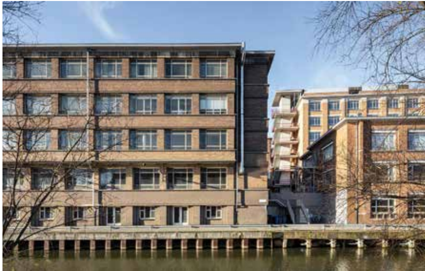
Oostgevel Technicumcomplex met nieuwe trapkoker aan T2 © Tim Van de Velde
