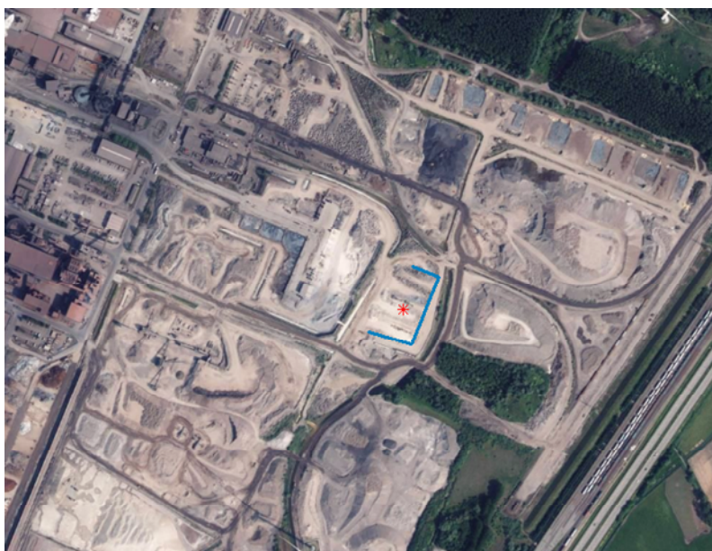
Figuur IX-55: Locatie gronddam langs MRP installatie
