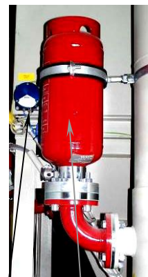
Blusscilinder met druksensor van een explosieonderdrukking
