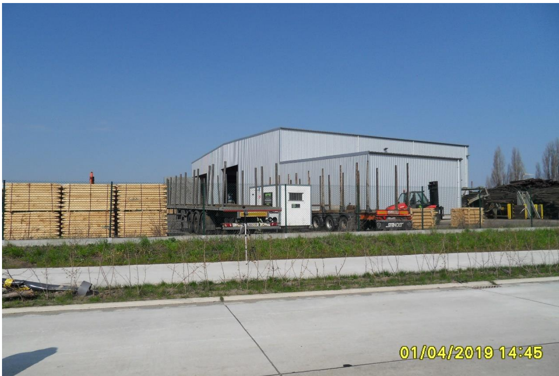
Foto 2. Zicht op de afvoeropeningen in de achtergevel van de brekerloods, gezien vanaf de Buitensingel.
