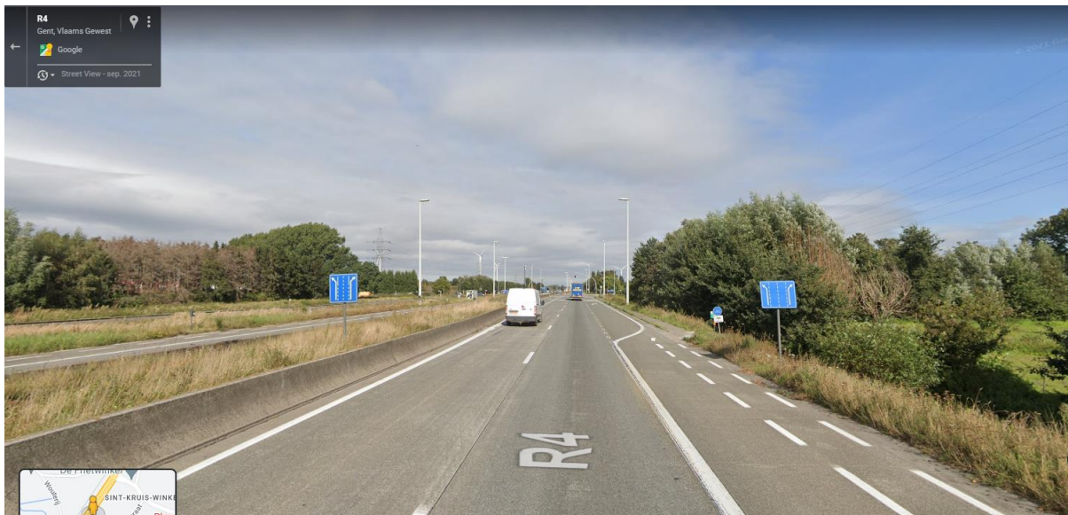
Figuur XV-6: Zicht op de R4 nabij kruispunt met Smishoekstraat (bron: Google street view).
